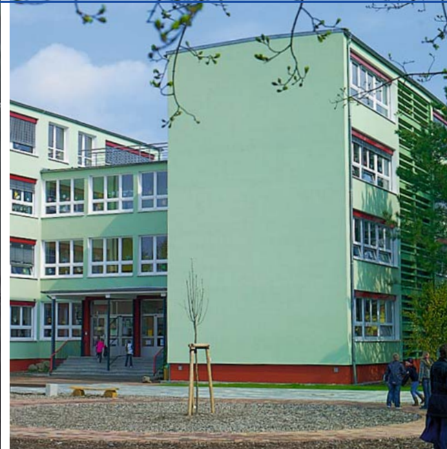
Frisch saniert: die Ganztagsgrundschule Friedland.
